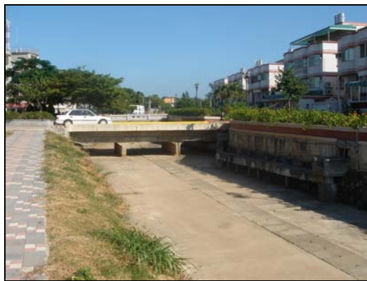
圖 4 超大型排水渠道
