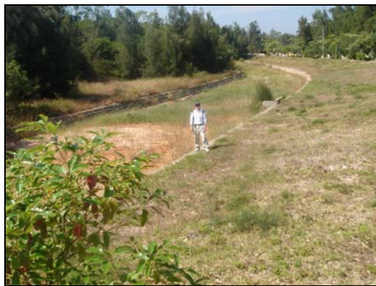
圖 3 超大型排水渠道
